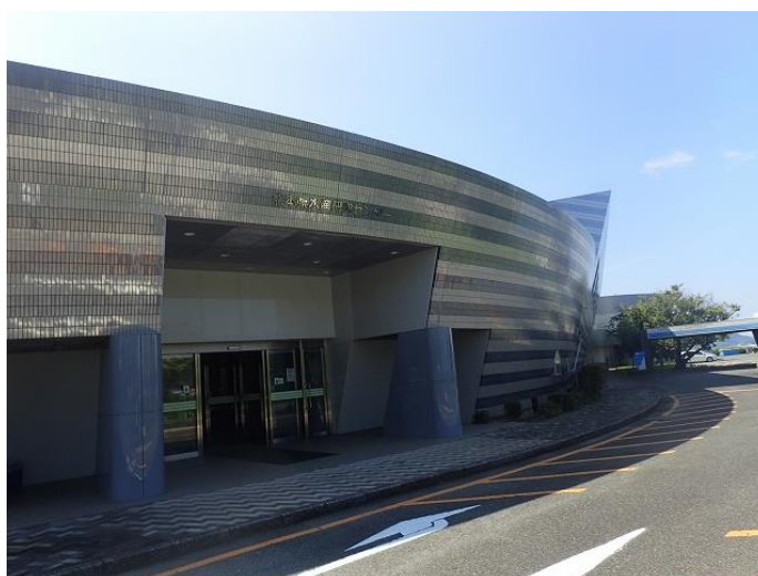
熊本県水産研究センターの外観。建物は船をイメージしたユニークな造り
