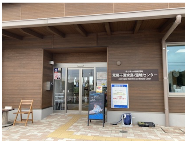
荒尾干潟水鳥・湿地センターの外観
